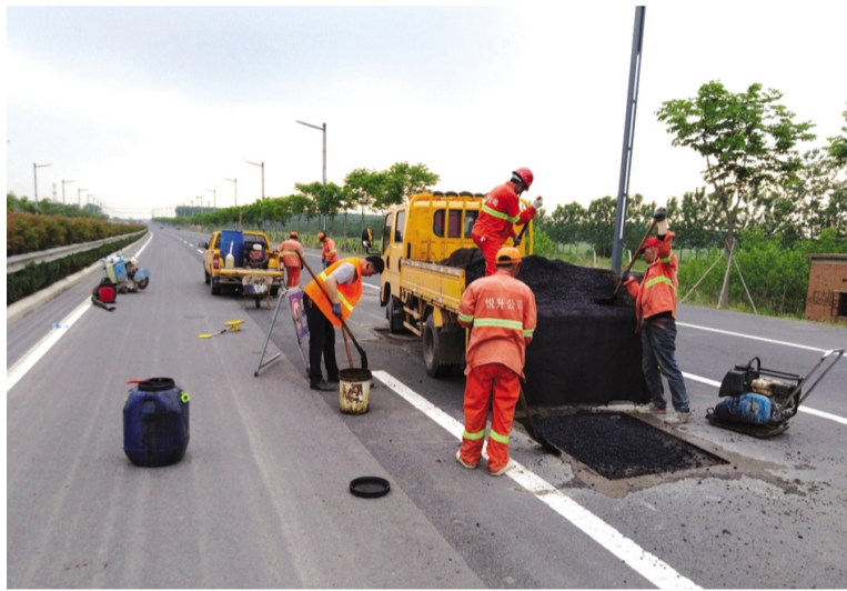
连日来,徐圩悦升市政分公司全体干群顶烈日、战高温,加班加点,对徐新路、苏海路、海滨大道等损坏路面进行维修,坚持每天工作8小时以上,现在已经高质量完成300余平方米道路坑塘修补工程,促进市政维修信誉提升,促进市政业务拓展升级提供保障。(王绪军)
