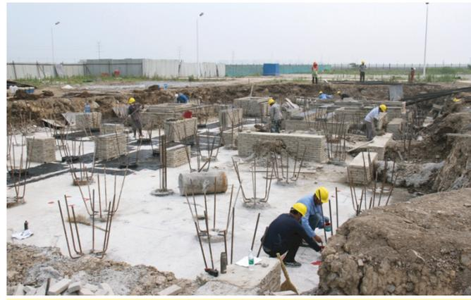
近日,利海化工公司为加快氯化苈二期项目进度,与施工单位协调,加大人力投入,确保工程按时间节点保质保量完成。图为氯化苈二期项目基础工程已进入钢筋制作安装阶段。(黄鑫)
